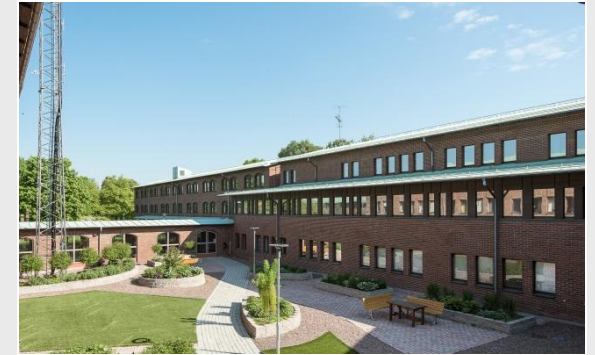
Borlänge, Spännaren 10 Borlänge town hall, tenant is Borlänge municipality
