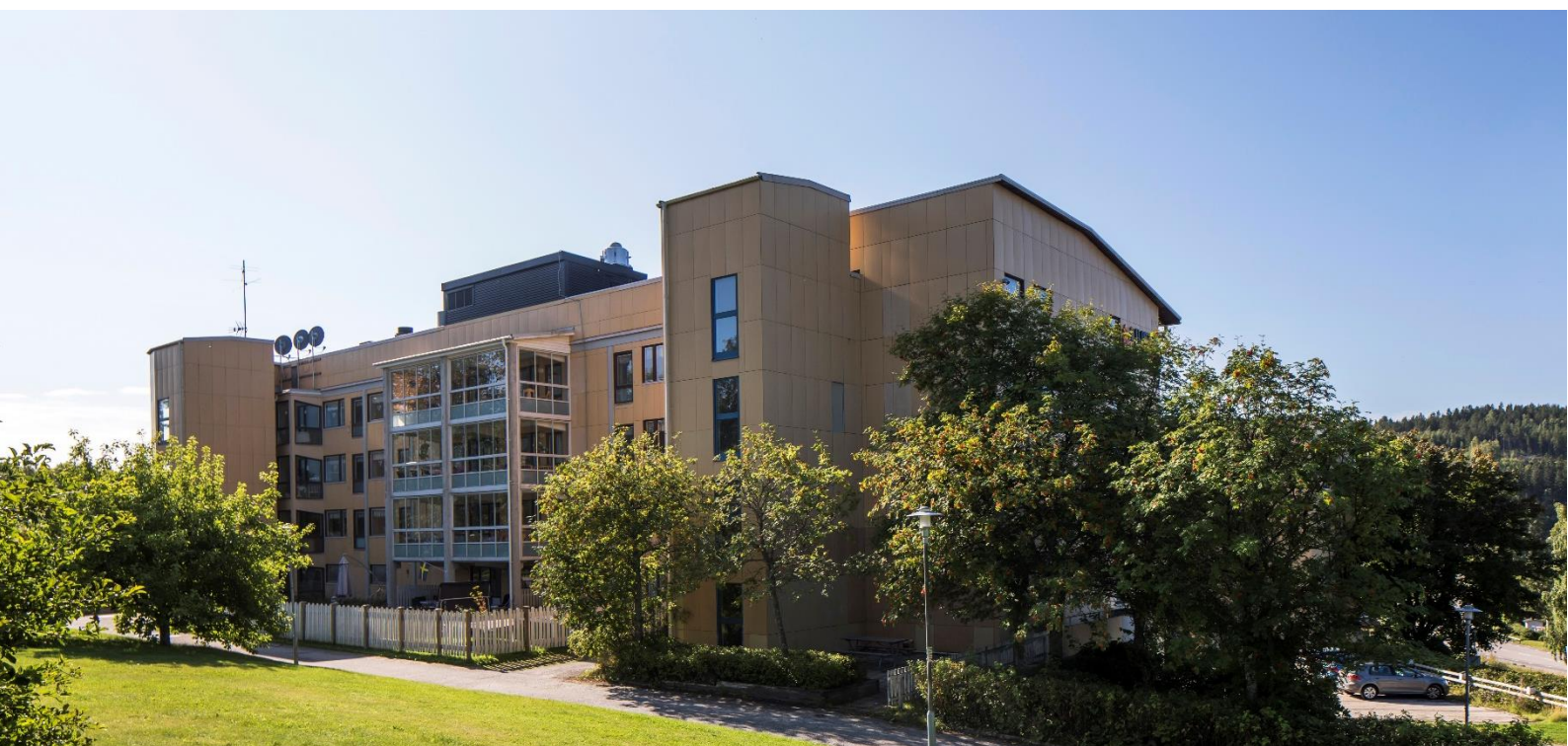
Exteriörbild från fastigheten Härsta 9:5, Sundsvall.
