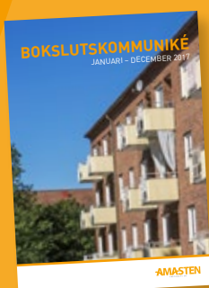
Fastigheten på omslaget är Magistern 23, Härnösand.
